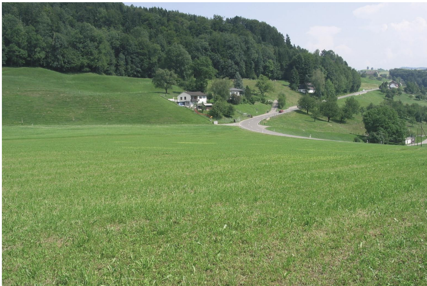
Ehemalige Deponie Baarburg, wie sie sich nach der Sanierung präsentieren wird.
