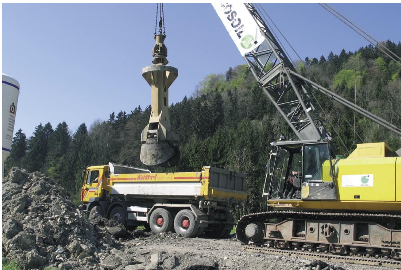
Baustelle für Sanierung der Basisentwässerung
