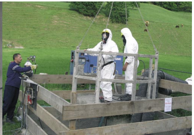
Höchste Sicherheit für Sanierungsarbeiten
