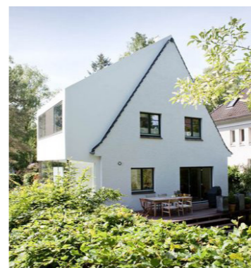
4 An- und Umbau Wohnhaus, Blankenese (D) einszueins Architekten
