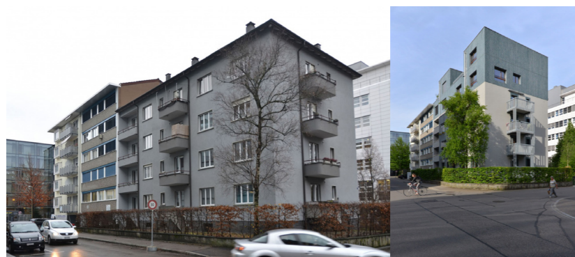
1 Gesamtanierung und Aufstockung MFH Salstrasse, Winterthur, Hinder Kalberer Architekten
