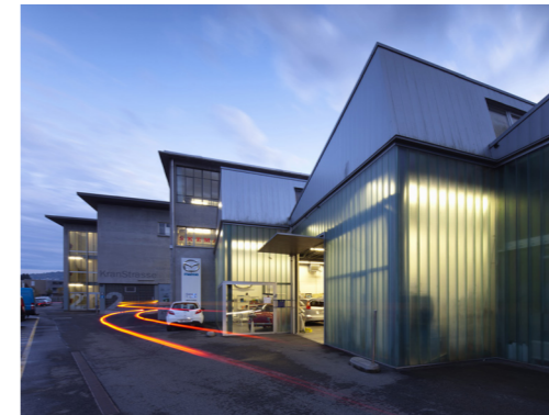
6 Renovierte Vidmarhallen in Köniz
