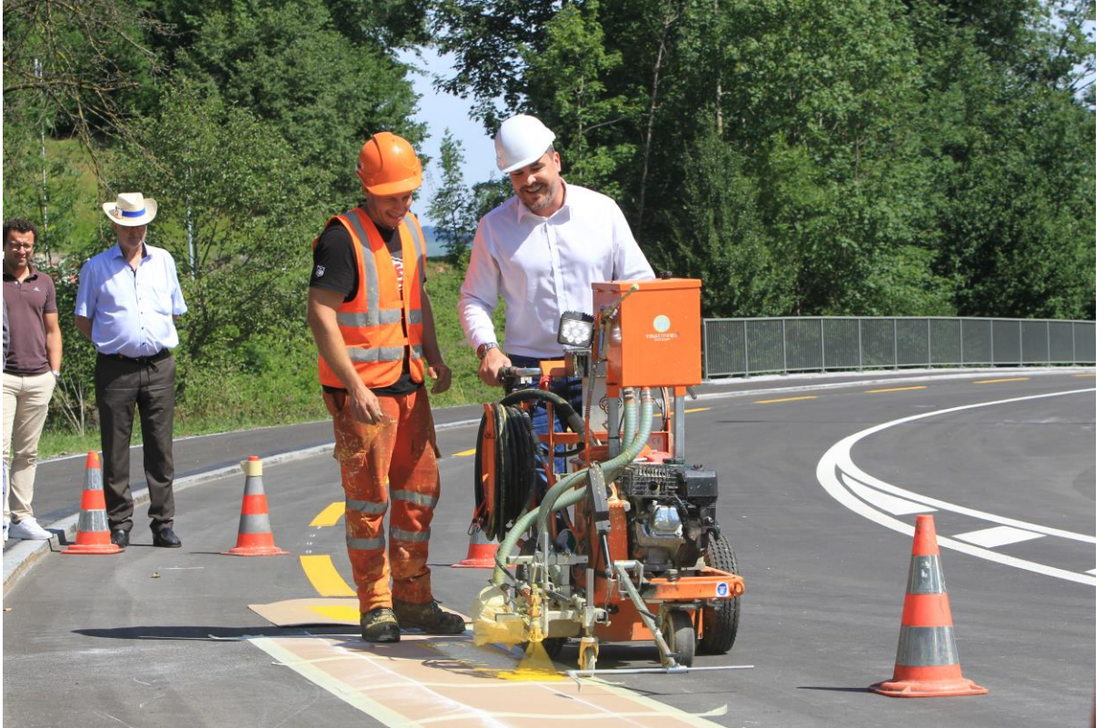
Baudirektor Florian Weber (rechts) bringt mit dem Bodenmarkierungsgerät symbolisch einer der letzten Radstreifen auf den Deckbelag der sanierten Strecke Nidfuren–Schmittl an.
