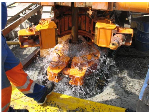
Wärme aus dem Untergrund: Bau eines Grundwasser-Entnahmebrunnens in der Stadt Zug.
