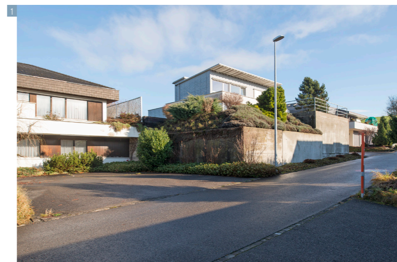
1 Gartenmauern, Garagen und Vorplätze prägen das Bild der Quartierstrasse Sonnhalde. 2 Luftbild mit Quartierperimeter
