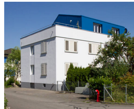
3 Umbau und Aufstockung Wohnhaus, Suhr (AG) Stierli Architekten
