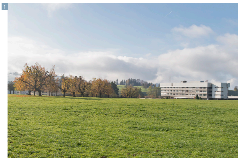
1 Das Pflegeheim St. Franziskus ist bereits von Weitem sichtbar. 2 Luftbild mit Quartierperimeter
