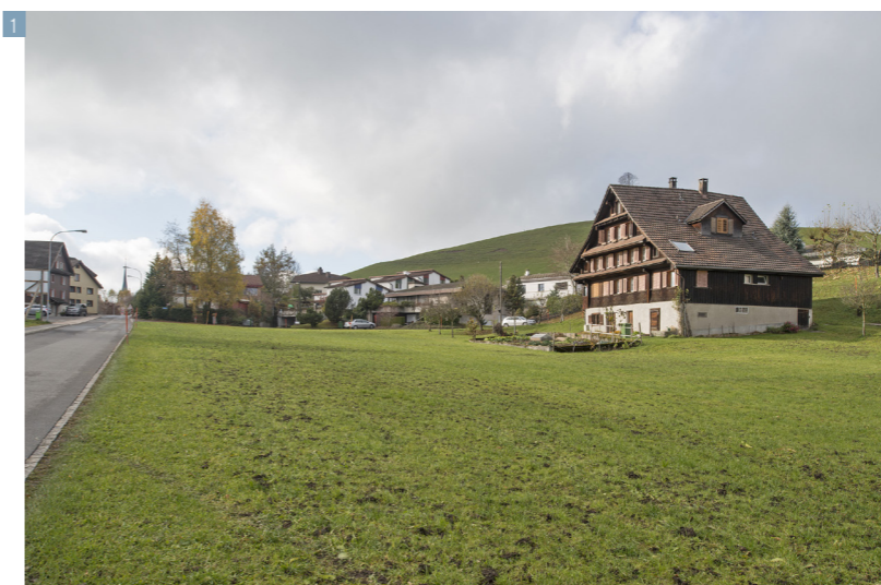
1 Das historische Wohngebäude grenzt an die unbebaute Bauzone und bildet den Auftakt in das Quartier. 2 Luftbild mit Quartierperimeter
