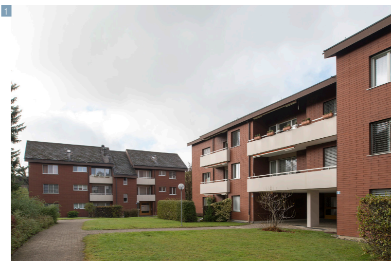
1 Die dreigeschossigen Bauten formieren sich um den gemeinschaftlichen Freiraum. 2 Luftbild mit Quartierperimeter
