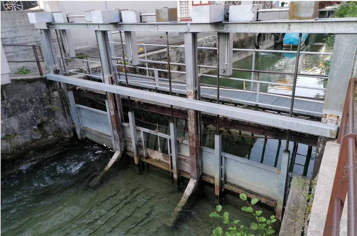
Abbildung 5 – Wehranlage zur Regulierung des Ägerisees
