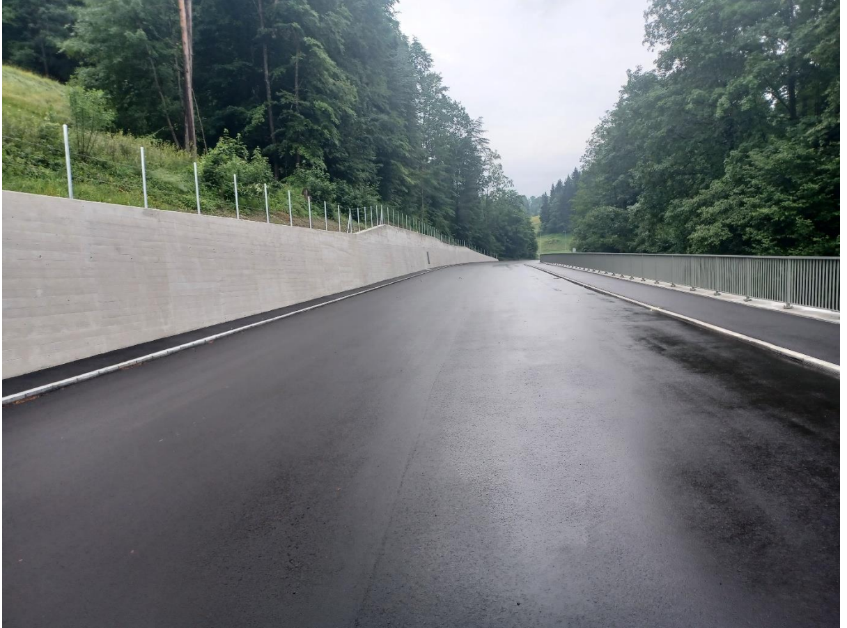
Der Abschnitt mit der bergseitigen Stützmauer Cholrainriedli der Strecke Nidfuren–Schmittli ist bis auf die Markierungen zur baldigen Eröffnung bereit.
